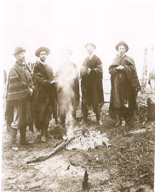
Engenheiros da turma junto ao fogo ( 5 graus abaixo de zero) The team's engineers at the fire (5 degrees below zero)
