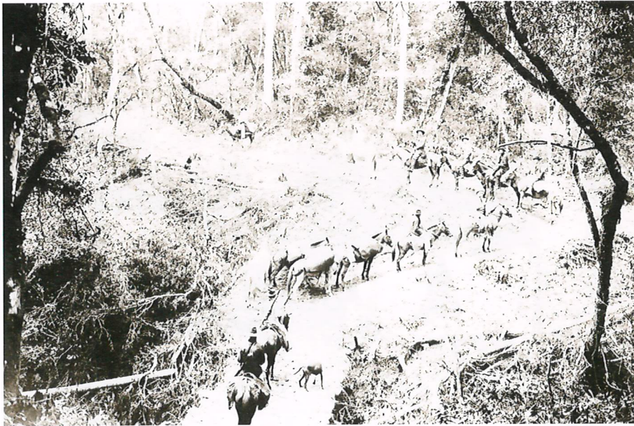
Picadão – Ponte do Tombo Tombo Bridge Trail
