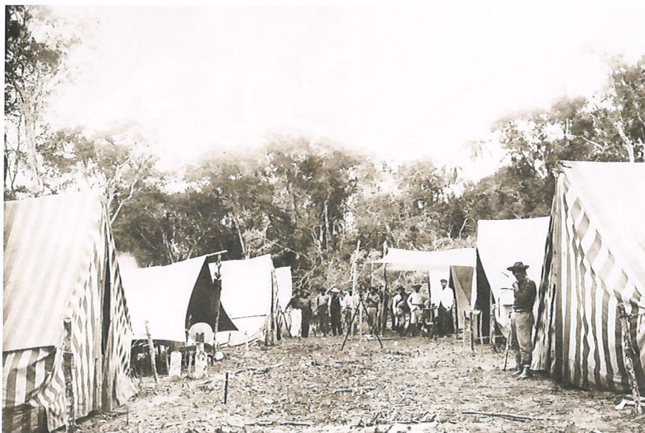
Acampamento do Brejão Brejão Camping site
