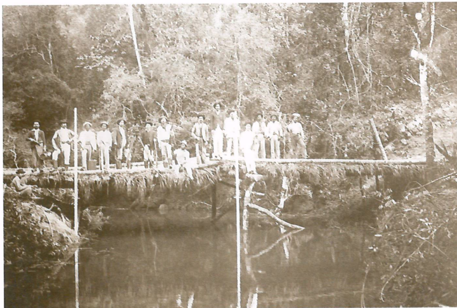
Ponte sobre o Rio Feio A bridge over Feio River
