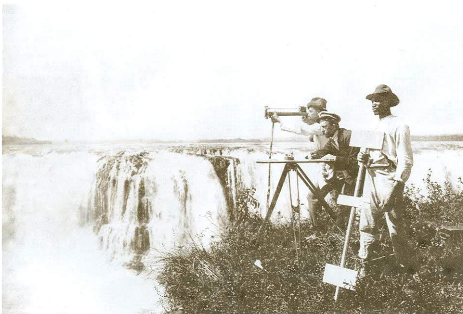
Levantamento dos detalhes – Salto dos Patos Details survey - Patos Fall
