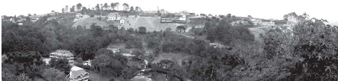
FIGURA 9 - Morro do nível intermediário (1710/40m), no alto da Vila Inglesa. Exemplo da ocupação de áreas mais estáveis por residências de alto padrão, construídas em terrenos amplos nos topos de morro e lombas.
