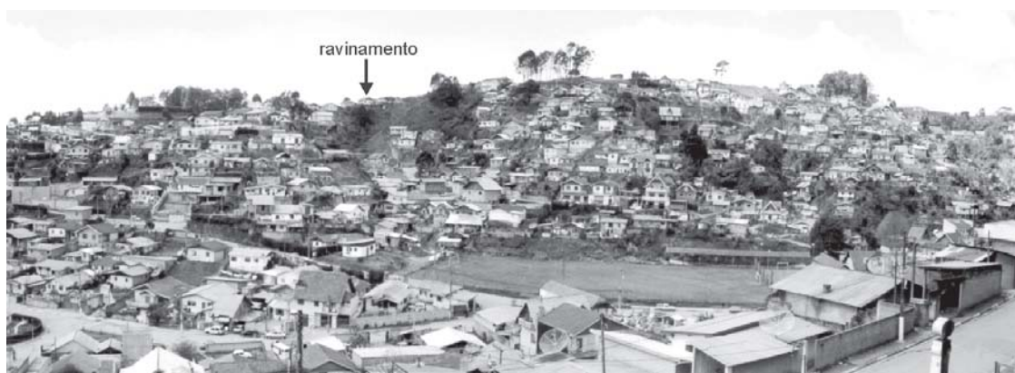
FIGURA 23 - Vila Sodipe, exemplo de ocupação inadequada e densa de vertentes íngremes. No centro da foto, residências de baixo padrão construídas na borda de ravinoamento profundo.
