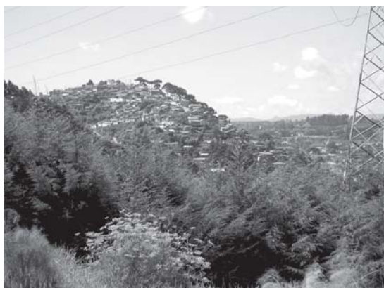
FIGURA 14 - Morro do nível intermediário (1718m) com vertentes retilíneas de declividade superior a 35° ocupadas por residências de baixo padrão (Vila Santo Antônio).
