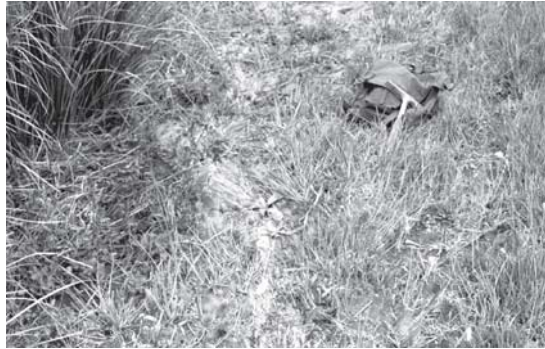
FIGURA 10 - Depósito de areia branca sobre cobertura de campo, evidência da ação do escoamento superficial anastomosado e erosão laminar intensa.
