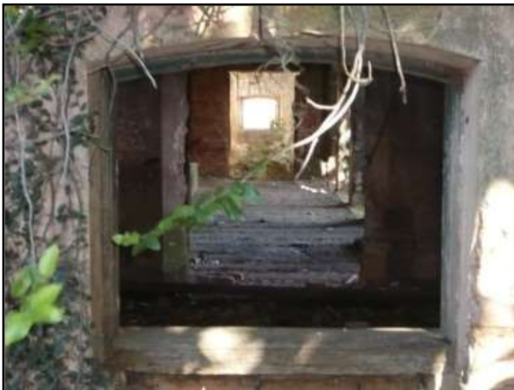
Imagem 29. Esquadria de madeira utilizada na janela. Foto: Sueli Herculiani, 2012.
