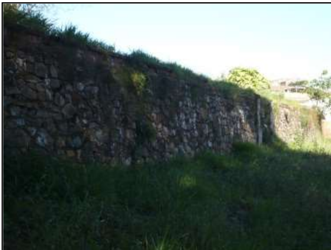
Imagem 31. Muro de arrimo construído em pedra. Foto: Sueli Herculiani, 2012.
