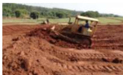
Figura 4 – Trecho 2 da Estrada Municipal Domingos Papa – BTC-080 – Adequação de 1,7 km de extensão onde o PDRS Microbacias apoiou R$37.861,20 e a Prefeitura Municipal de Botucatu apoiou R$4.206,80, num total de R$42.068,00. Traçado em aclave/declive - técnicas utilizadas: abatimento e reconformação de taludes com 2 metros de altura média. Implantação de sistema de drenagem com caixas de captação e terraceamento. Alargamento da plataforma. Sub-base em piçarra e revestimento em pedra britada em bica corrida.
