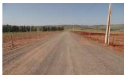
Figura 3 – Trecho 1 da Estrada Municipal Domingos Papa – BTC-080 – Adequação de 2,4 km de extensão onde o PDRS Microbacias apoiou R$45.144,00 e a Prefeitura Municipal de Botucatu apoiou R$5.016,00, num total de R$50.160,00. Técnicas utilizadas no traçado em espigão: implantação de sistema de drenagem e revestimento da pista de rolamento com pedra bica corrida.
