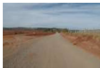
Figura 3 – Trecho 1 da Estrada Municipal Domingos Papa – BTC-080 – Adequação de 2,4 km de extensão onde o PDRS Microbacias apoiou R$45.144,00 e a Prefeitura Municipal de Botucatu apoiou R$5.016,00, num total de R$50.160,00. Técnicas utilizadas no traçado em espigão: implantação de sistema de drenagem e revestimento da pista de rolamento com pedra bica corrida.
