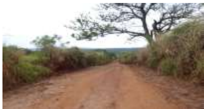
Figura 3 – Trecho 1 da Estrada Municipal Domingos Papa – BTC-080 – Adequação de 2,4 km de extensão onde o PDRS Microbacias apoiou R$45.144,00 e a Prefeitura Municipal de Botucatu apoiou R$5.016,00, num total de R$50.160,00. Técnicas utilizadas no traçado em espigão: implantação de sistema de drenagem e revestimento da pista de rolamento com pedra bica corrida.
