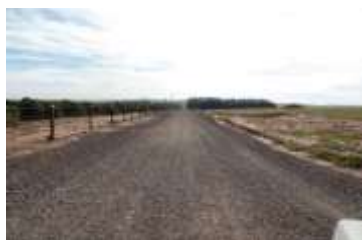
Figura 3 – Trecho 1 da Estrada Municipal Domingos Papa – BTC-080 – Adequação de 2,4 km de extensão onde o PDRS Microbacias apoiou R$45.144,00 e a Prefeitura Municipal de Botucatu apoiou R$5.016,00, num total de R$50.160,00. Técnicas utilizadas no traçado em espigão: implantação de sistema de drenagem e revestimento da pista de rolamento com pedra bica corrida.
