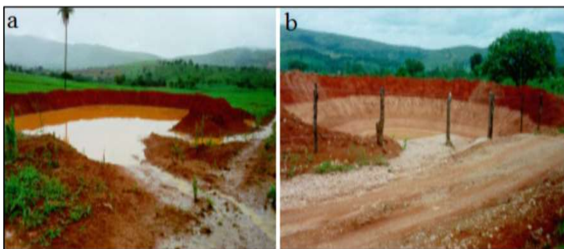
Figura 3. Bacia de captação do escoamento da água: a) cheia após a chuva, b) infiltração da água e reabastecimento do lençol freático.
