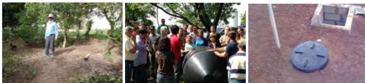
Figura 2. Biodigestores: Antes, durante e após instalação.
