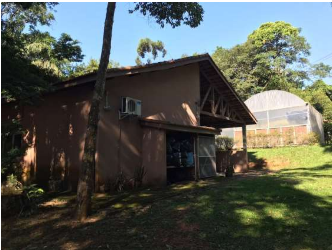
VISTA DA PARTE LATERAL DO EDIFÍCIO
