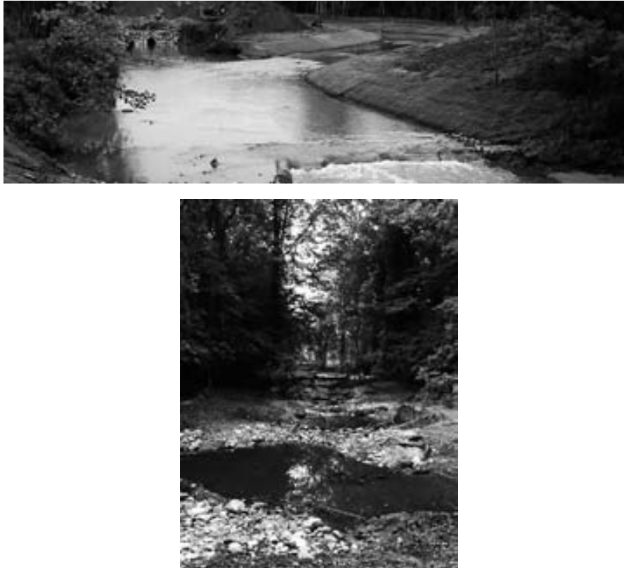
Figura 2. Exemplos de práticas de restauração de rios e córregos, implementadas no leito do rio ou dentro da calha, com o objetivo de estabilizar bancos e controlar a vazão.
