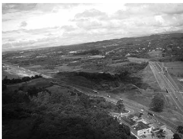
Figura 15 - Vista aérea das pistas do Trecho Sul do Rodoanel, na região da planície de inundação do rio Embu-Mirim.
